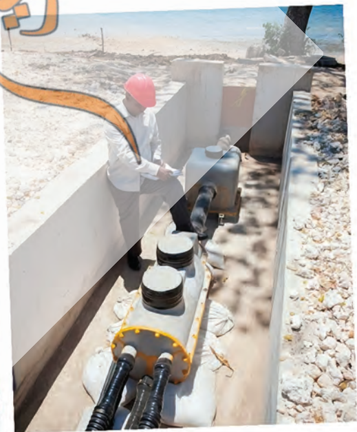
آزمایش کابل برق زیر دریایی در ساحل زانزیبار (زنگبار یا زنجبار)
